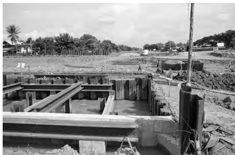
チャオプラヤ川沿いバンチョームシー水門の改修現場。2011年大洪水による破壊の後、全面的に設計を見直した再建工事が進められている(2012年9月20日撮影)
