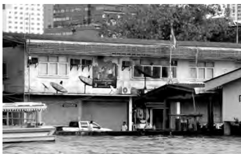
資料1-9 チャオプラヤ川沿いの防水壁
