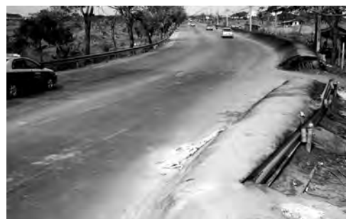
資料1-10 バンコク東岸輪中堤防
