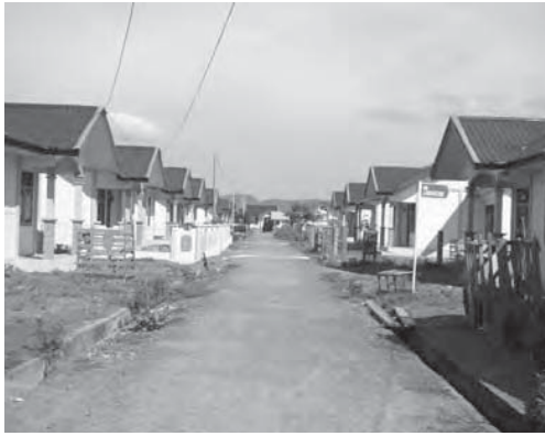
資料35 区画整理された「理想の復興住宅地区」 電線が引かれていない家が多く見られる
