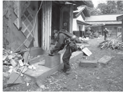
資料12 壁が落ち、崩れかけた土蔵での救出作業
