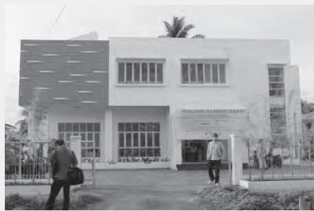
シアクアラ大学のHyogo Prefecture Building
