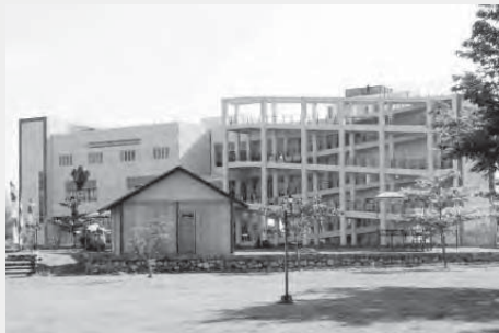
裏手(集団埋葬墓地)側から見たTDMRC。避難階段が見える
