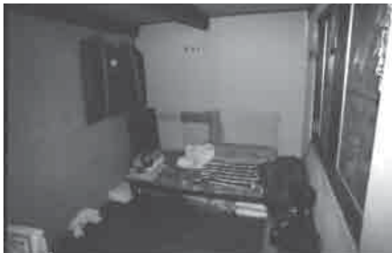
写真1-5-7 タイで供給された住宅の10年後。2階はつくっていない ※写真1-5-5~8は田中麻里氏撮影。出典：田中麻里『タイの住まい』園津喜屋刊、2006年
