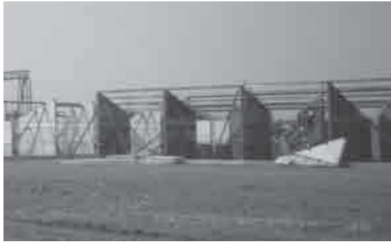
写真1-5-5 タイ(トゥンソンホン地区)の住宅。屋根に鉄骨桁梁がある
