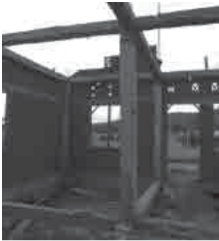
写真1-5-3 柱の太さと梁の高さ(水平方向の厚み)がほぼ同じになっている
