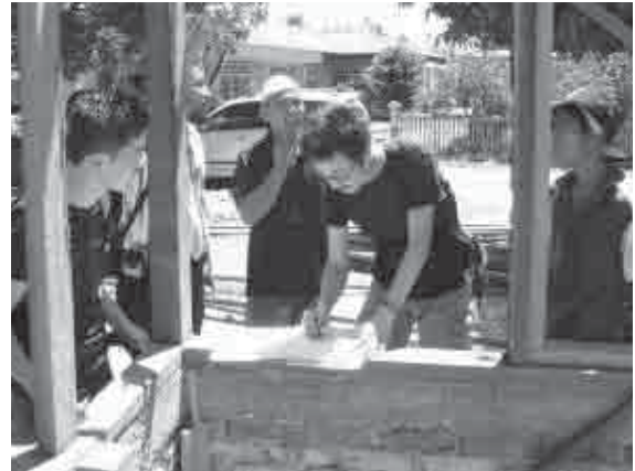
写真1-2-3 建設現場で建物の安全性を高める方法についてその場で指導を実施
