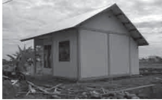
写真1-5-2 被災後に供給された建物。色の濃い部分がコンクリート枠
