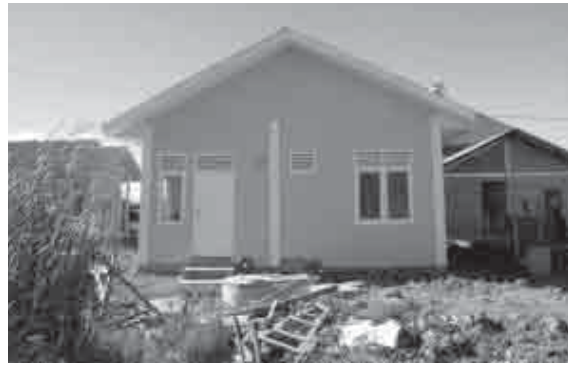
写真1-5-4 上の梁がない住宅
