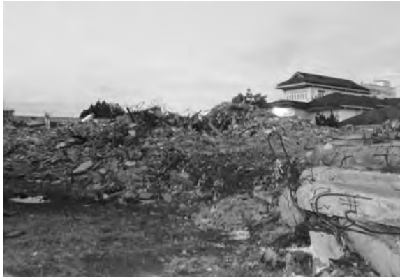
パダン市内の図書館跡。地震のため建物が全壊し、所蔵されていた図書のほとんどが失われた。
