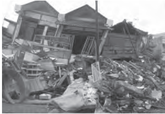
写真3-3 木造家屋の倒壊現場（パダン市内）
