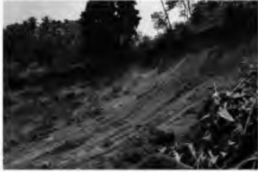
村落部の被災状況(パダン・バリアマン県)
