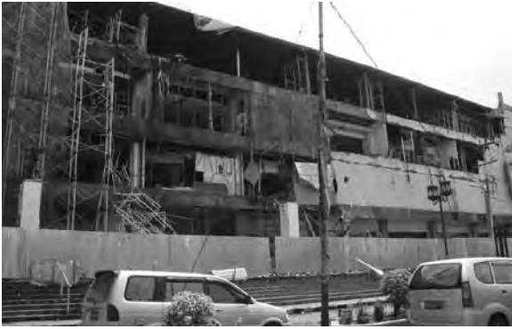
パダン市内。2階建て以上の建物が多く被害を受けた。左の写真は4階建てのショッピングセンター。
