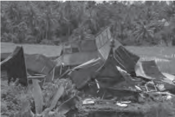
写真3-4 民家の倒壊が激しい村落部（パダンパリアマン県）
